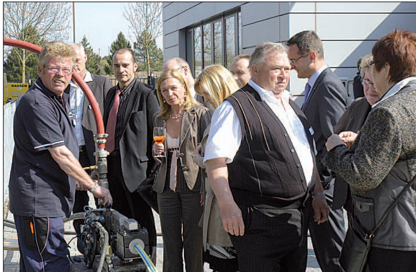
Vorführungen der Tätigkeitsfelder von OFM, insbesondere die Verlegung von Glasfaserkabeln, beeindruckten die Ehrengäste.
